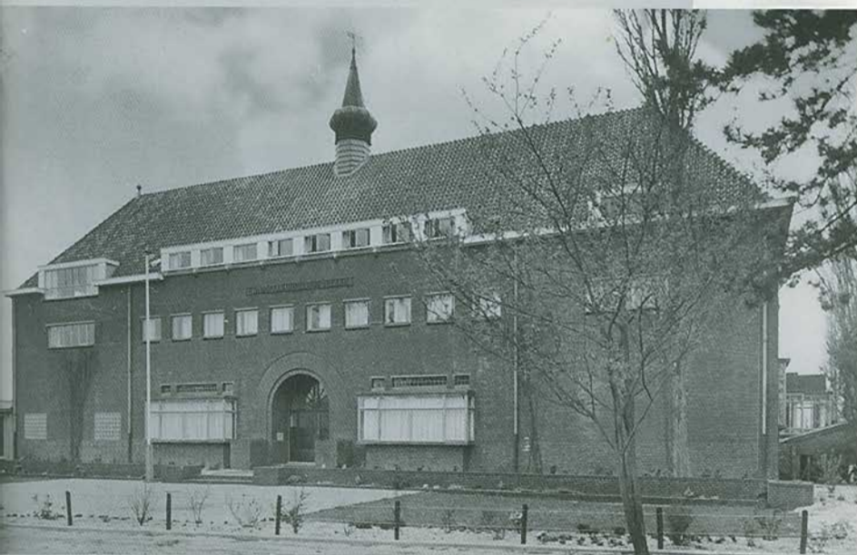
De landbouwhuishoudschool, gebouwd in 1932. (Ansicht collectie auteur).
